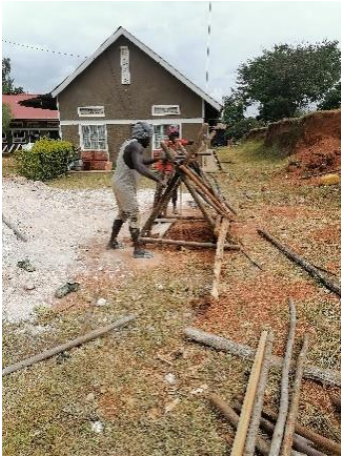
Brunnenbohrung in Bwanda
