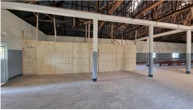
Trennwand im Speisesaal in der Gehörlosenschule Rwera
