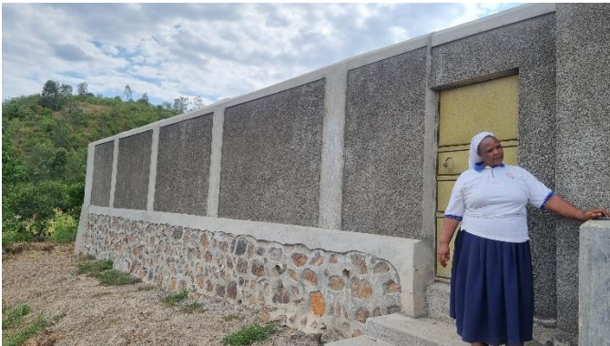
Umgestürzte Mauer wurde wieder hergerichtet.
