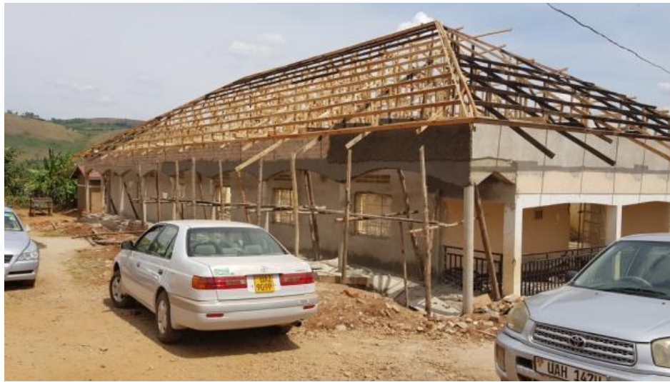
Sanierung des Speisesaals
