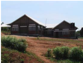
Neu seit 2007: links sieht man den neu gebauten Speisesaal, rechts die Küche.
