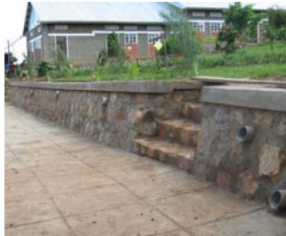
Vor kurzem wurde die Stützmauer mit Treppe fertig gestellt.
