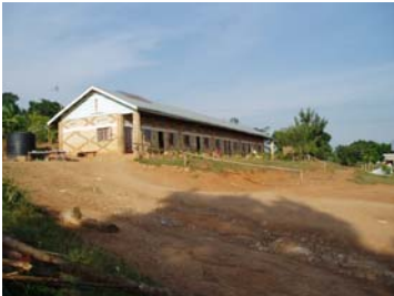
Das erste Schulgebäude (2001).
