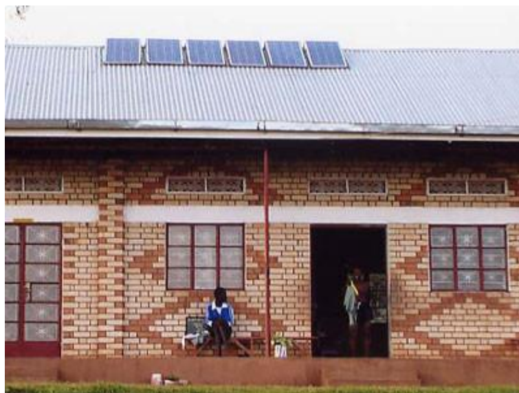
Die Solaranlage wurde auf dem Dach der Schule angebracht
