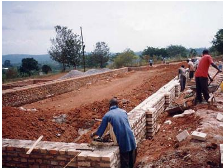
Bau des Speisesaals mit Küche, das Fundament ist fertig
