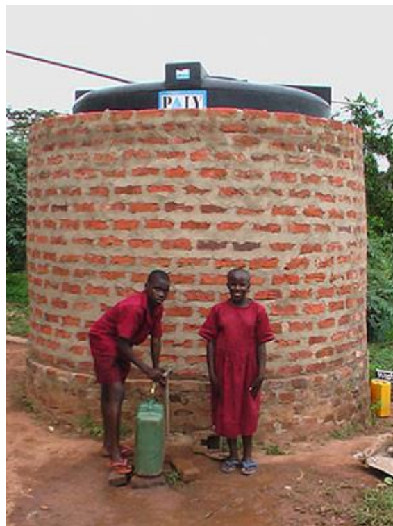
Der 10.000 Liter Wassertank. Errichtet von den Sponsorengeldern
