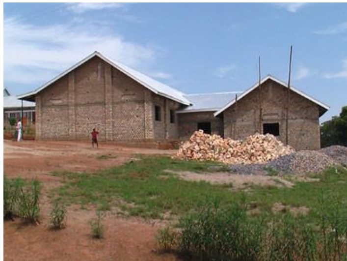
Der Speisesaal und die Küche im Rohbau
