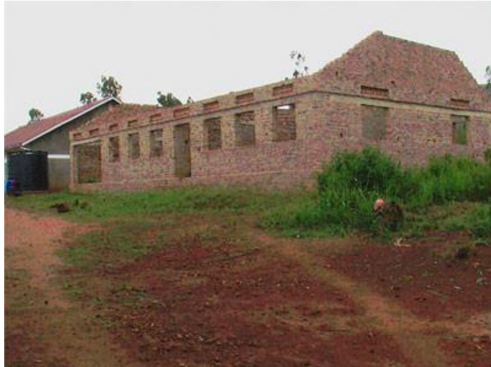
(Ntungamo) Im Rohbau: Schlafsaal für Mädchen
