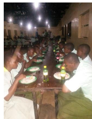
Helle Beleuchtung mit Solar im Speisesaal
