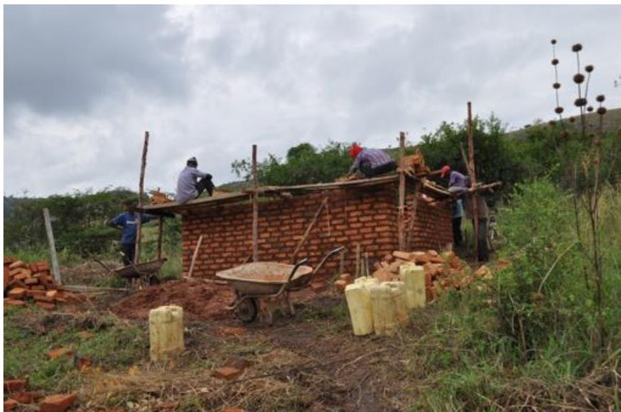
Dieses Projekthaus soll später als Speicher verwendet werden. Die Auszubildenden werden erst das Betonieren des Fundaments, den Gerüst-Aufbau, das Mauern, den Dachstuhlbau, das Verputzen, den Fenster- und Türeinbau erlernen. Es ist auch geplant, dass sie mit hörenden Bauarbeiter den Schlafsaal der Buben bauen, um mehr praktische Bauerfahrung zu bekommen. Diese Auszubildenden haben bessere Chance, später einen
