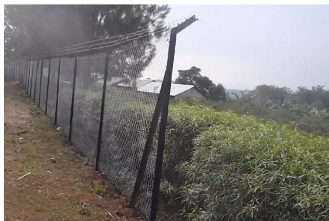
Der Zaun im Bau
